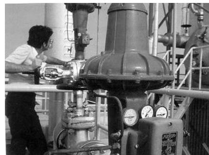
Fig. 17.18. Operador atuando no processo
